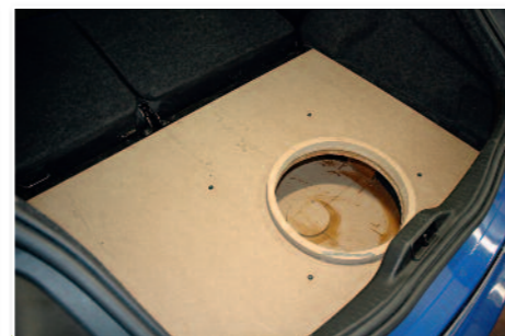
Mise en place d'une flasque au dessus du caisson pour accueillir le matériel.
